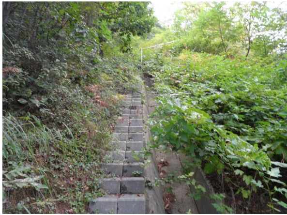
산마루측구, 점검계단 전경
